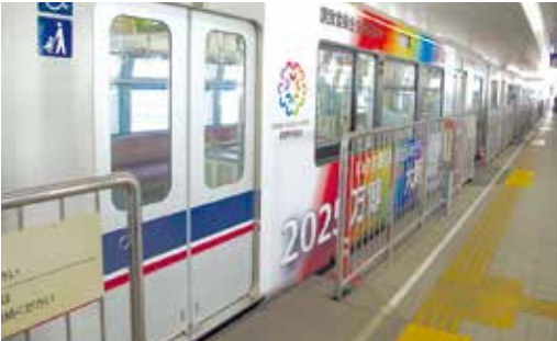
可動式ホーム柵設置予定のモノレール門真市駅の様子
