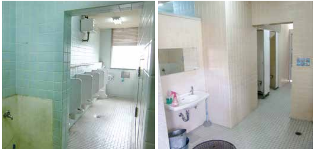
改修予定の二島小学校のトイレ
