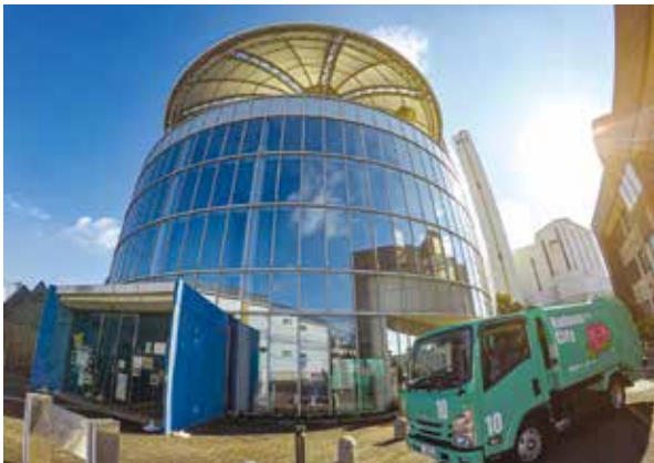
深田町にあるクリーンセンターとごみ収集車
