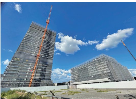
再開発が進む古川橋駅北側
