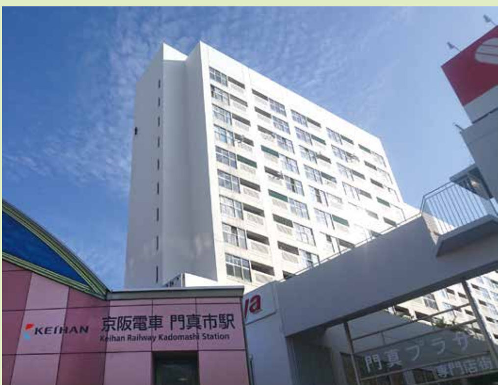
再整備を検討している新橋市営住宅と門真ブラザ
