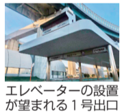
エレベーターの設置が望まれる1号出口
