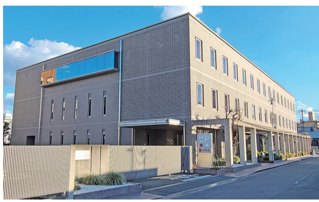
教育センターが移転する門真中町ビル (旧松心会館)
