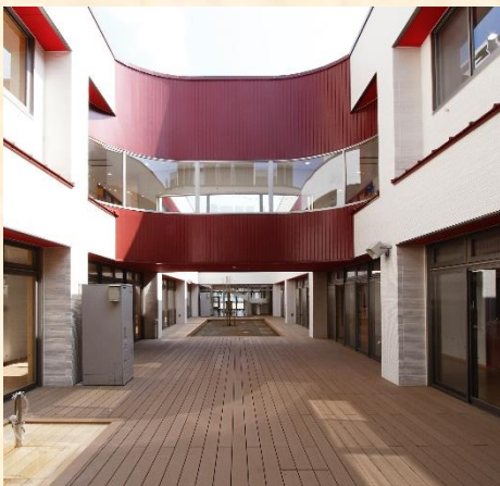
門真市立砂子みなみこども園新設
