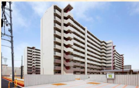
門真市営住宅 新築工事
