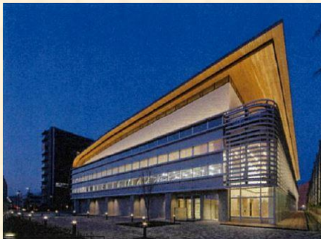
門真市立総合体育館 新設
