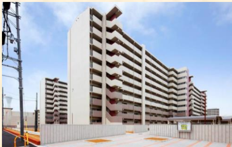
門真市営住宅 新築工事
