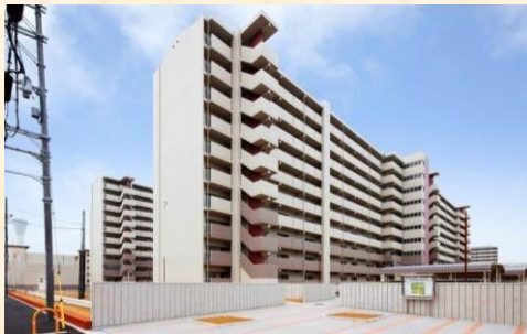
門真市営住宅 新築工事
