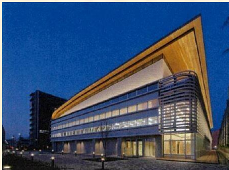
門真市立総合体育館 新設
