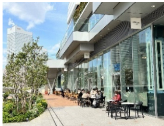
低層部の開かれた賑わい空間 (横浜市役所)
