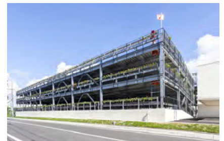
【壁面緑化した自走式立体駐車場の例】
