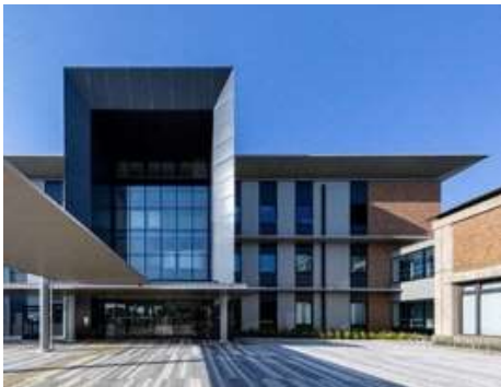
ZEB Ready 導入事例（高島市庁舎）
