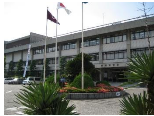
耐震性を満たしていない庁舎
