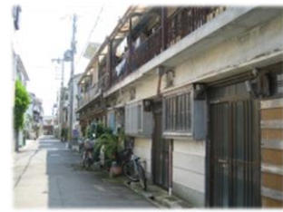
木造賃貸住宅・幅員4m道路
