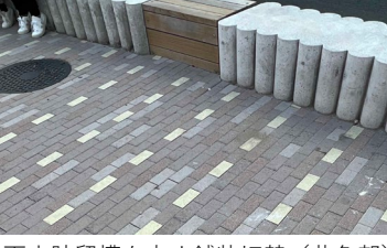
雨水貯留槽を表す舗装切替（黄色部）
