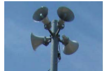
防災行政無線 屋外スピーカー
